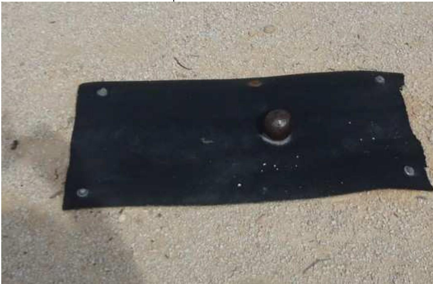
Un morceau de caoutchouc épais planté dans le sol avec des clous de 150, percé pour installer une boule soudée sur une barre d'acier enfoncé dans le sol afin de ne pas
