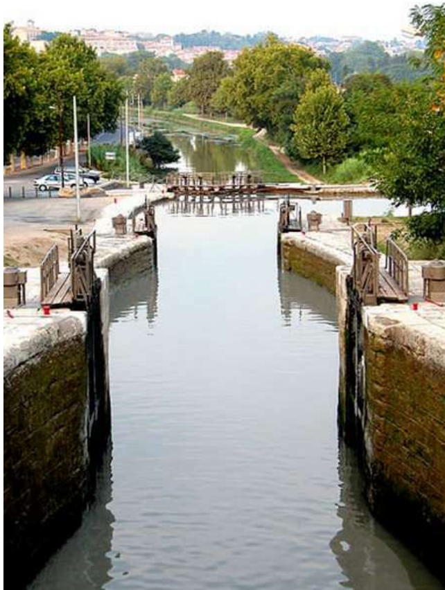
Les 7 écluses de Fonserannes, un des ouvrages majeurs du Canal du Midi, au pied de la ville de Béziers
