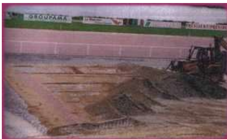
L'hippodrome de Bellevue la forêt à Laval, qui a accueilli ce Championnat entreprise Quelques travaux de terrassement ont été nécessaires, pour recevoir les pétanqueurs, juste devant la tribune de l'hippodrome Lavallois
