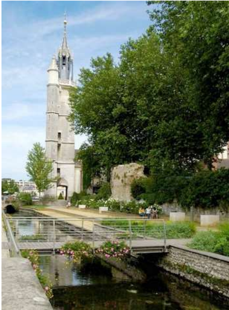
Le Beffroi de la Tour de l'Horloge à Evreux. Ce monument du Moyen-Age a pu être préservé des destructions de la seconde guerre mondiale
