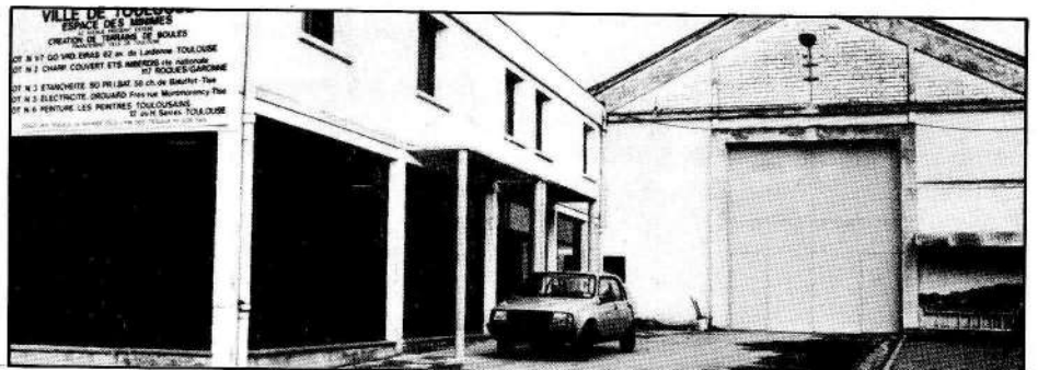
Vue extérieure, à gauche: bar, salle de réunion, bureau.
